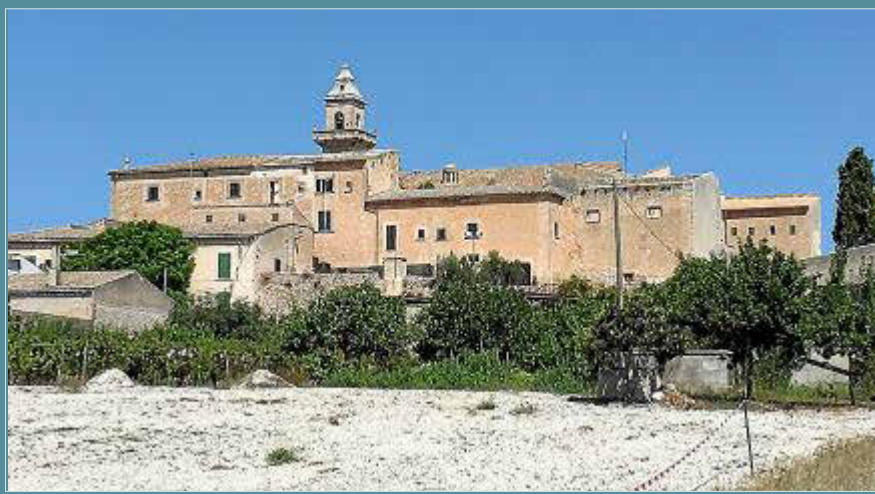
El Ajuntament negoció con el Obispado la compra del edificio. Foto: Archivo UH
